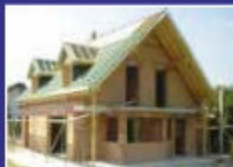
Baustoffe/Rohbau/ Sanierung auf 7000 m 2
