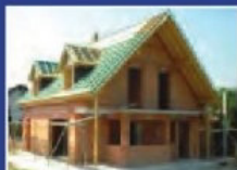
Baustoffe/Rohbau/ Sanierung auf 7000 m 2
